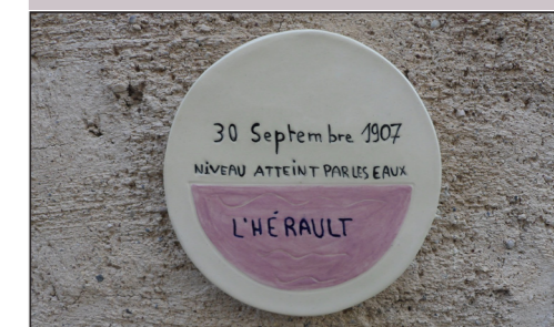
Repère de crue posé le 25 août 2014 rue de l'Ancienne Mairie
