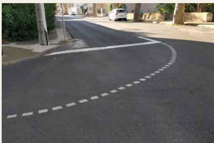
SÉCURISATION À L'INTERSECTION DU BD DE LA DIGUE
