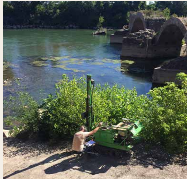
CONFORTATION DU PONT ROMAIN
