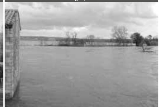
Pont totalement immergé par la crue du 4/12/2003
